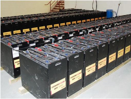
**그림 2-1** 480VDC에서 60KW를 제공하는 기업 데이터 센터의 백업용 배터리 어레이(Hybridne Power Systems, Canada, Inc.와 Hybridne group of companies 사의 허가를 받은 사진. 저작권은 Hybridne Power Systems Canada Inc.에 있으며, Hybridne의 승인 없이 복제 불가).
